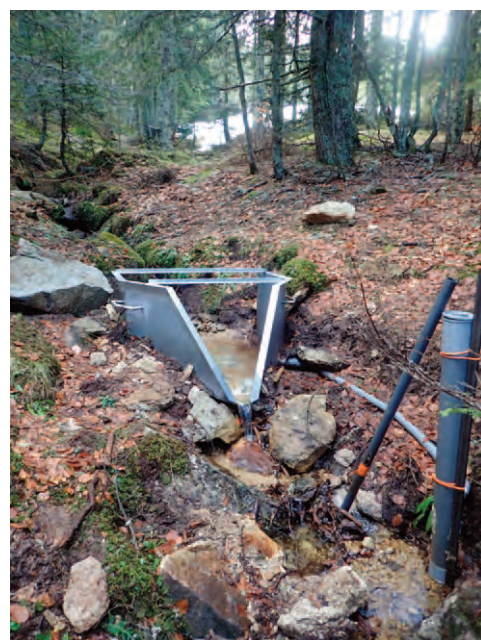
Débitmètre qui mesure le débit volumétrique des eaux de surface installé par l'ONF sur la zone d'étude du rôle des zones humides en forêt.
