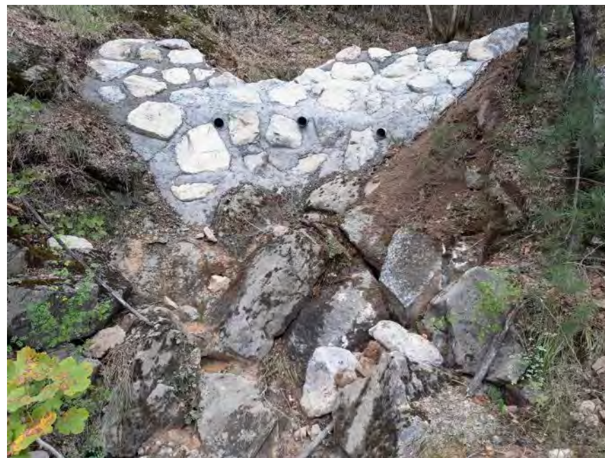
Seuil en enrochement– Photo ONF/RTM
