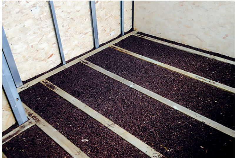
Photo 1 (ci-dessus) : Liège expansé en vrac pour l'isolation d'un plancher. © NaturalHome.com
