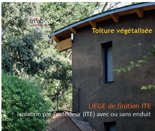
Photo 4 (ci-dessus) : Isolation par l'extérieur (Chantier Trihab).
