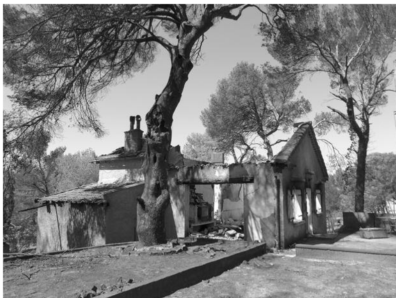
Photo 1 : Exemple d'habitation détruite lors du feu de Rognac, à noter en particulier le houppier de pin d'Alep dominant la toiture. Photo ONF
