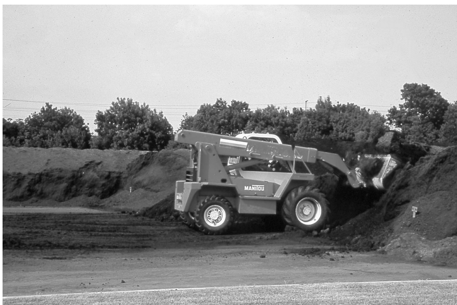
Photo 3 : Andain de compost de déchets verts et chargeur
