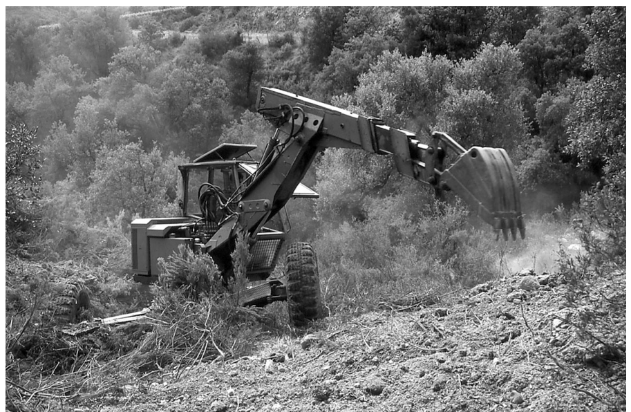
Photo 3 : Travaux réalisés à la pelle araignée
