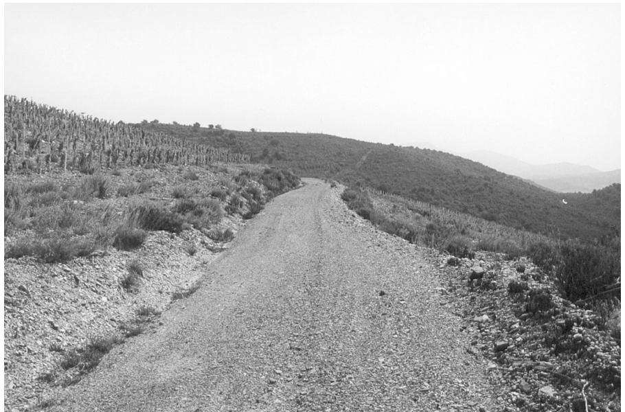
Photo 3 : Banquettes à contrepente (2 à 3%) et plantation de vignes en courbe de niveau à Embres dans les Corbières (1998)
