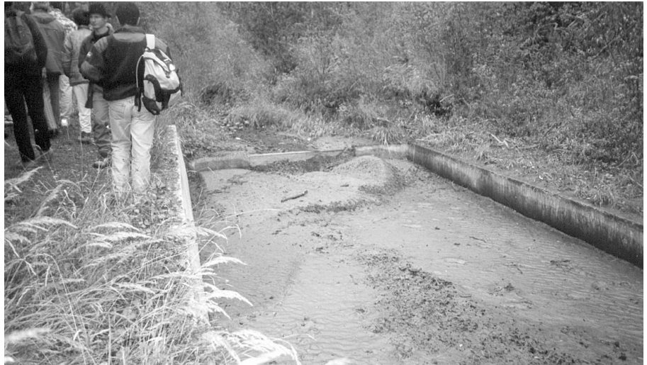
Photo 9 : Bassin de dépôt au Brusquet
