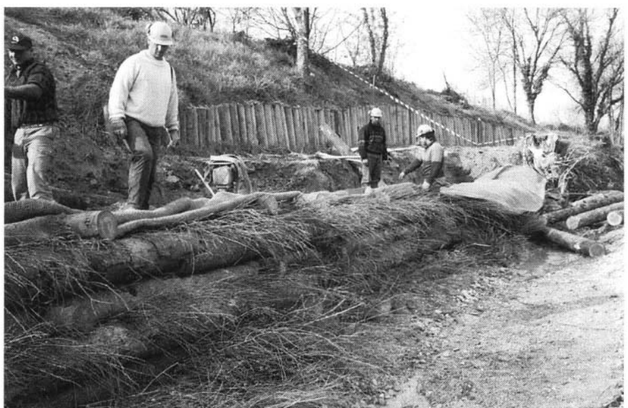
Photo 2 : Utilisation du génie biologique pour la réalisation d'ouvrages de protection de berge Photo SABA
