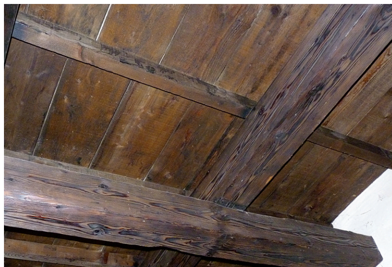
Photo 1 : Élément de charpente traditionnelle en pin d'Alep. Photo J.P. Mante, Fransylva 13.
