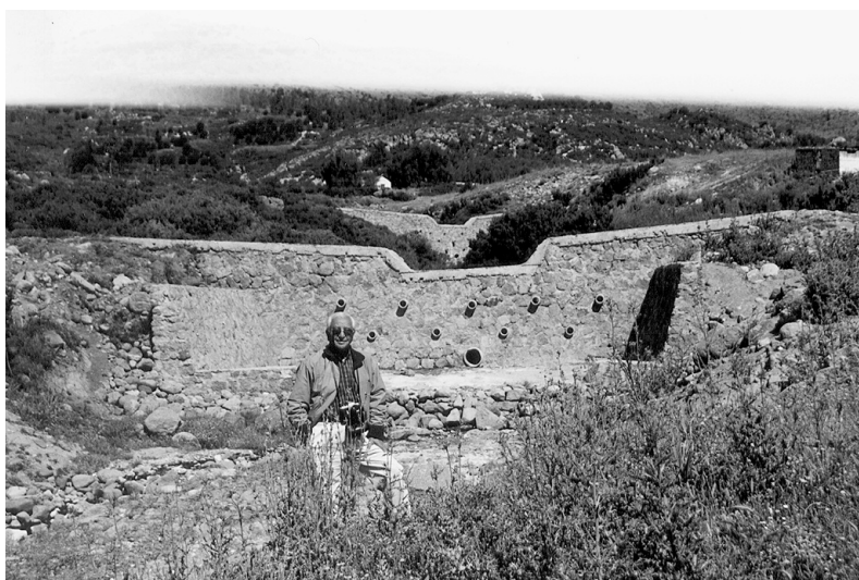
Photo 2 : Les barrages de restauration dans le torrent de Pamuk Bogazi (torrent qui rejoint le ruisseau de Bostanli)
