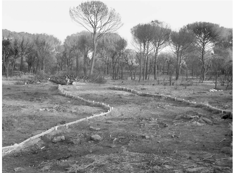
Photo 1 : Fascinage en courbes de niveau après abattage de la végétation morte sur pied.
