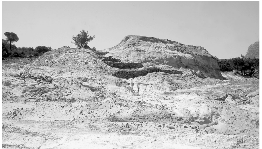
Photo 7 : Chantier expérimental de restauration d'anciennes carrières à Quat. Gabions, banquettes et plantations de pins pignons
