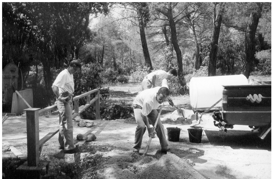
Photo 2 : Mise en place d'une barrière DFCI
