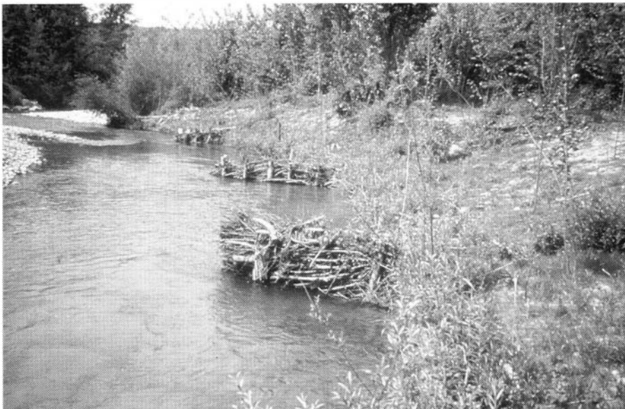
Photo 2 : Une palette de techniques végétales est à la disposition de l'aménageur pour assurer la protection des berges
