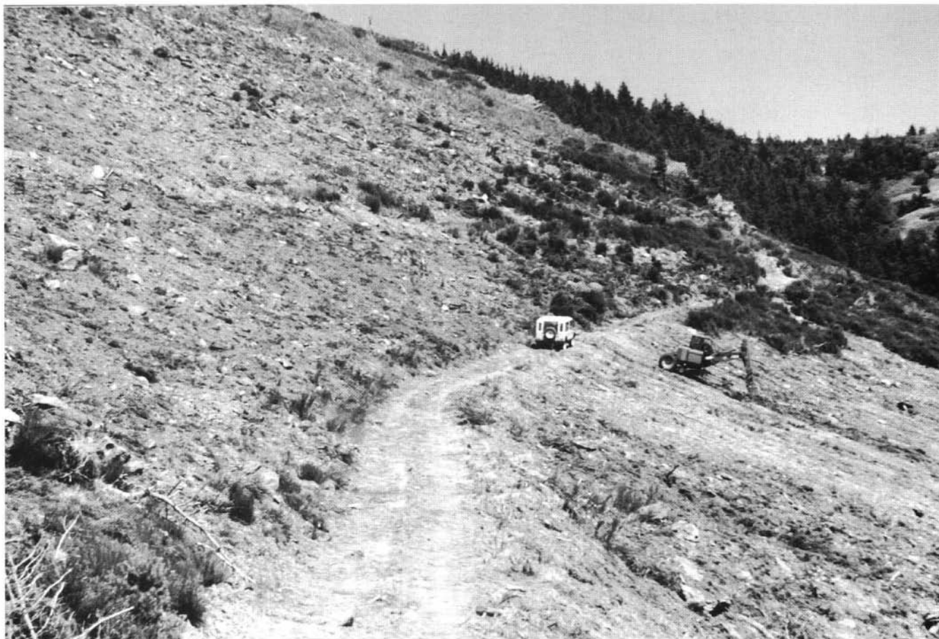
Photo 3 : Travail de la pelle-araignée en remontant la pente
