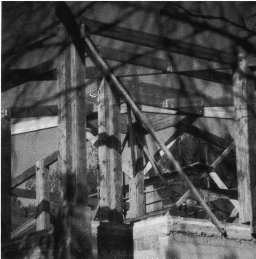
Photo 11 : Charpente en lamellé-collé du Centre forestier de la Bastide-des-Jourdans. Photo C.I.C.B.L.
