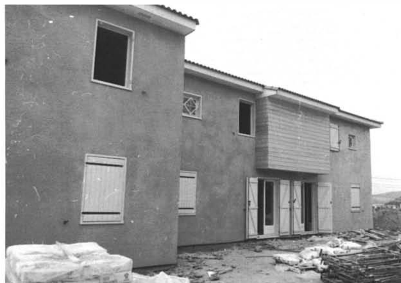
Des façades terminées : large part à l'enduit et peu au bois. Photo E. M.
