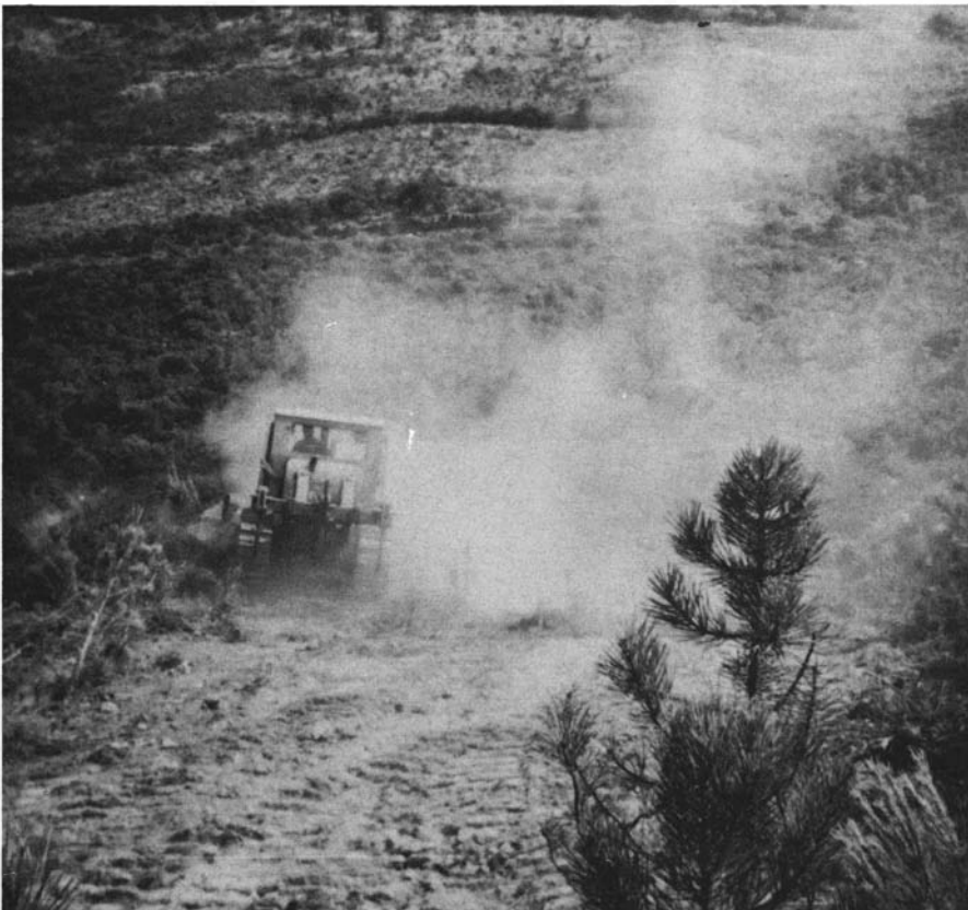
Photo 6. — Reboisement. Constitution d'andains antiérosifs au bulldozer.
