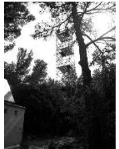
Photo : La tour à flux de Fontblanche est montée en échafaudage sur une vingtaine de mètres. Des capteurs sont situés à son sommet ainsi qu'à différents endroits du site. Photo DA
